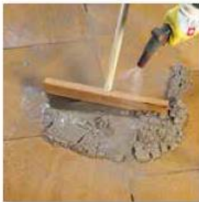
Einarbeiten mit Hartgummischieber und Wassersprühstrahl
