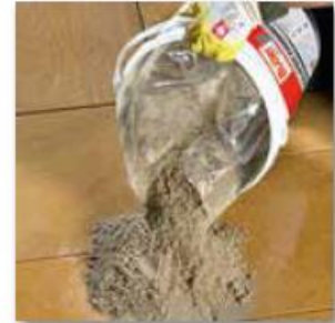
Portionsweises Aufbringen des Fugenmörtels
